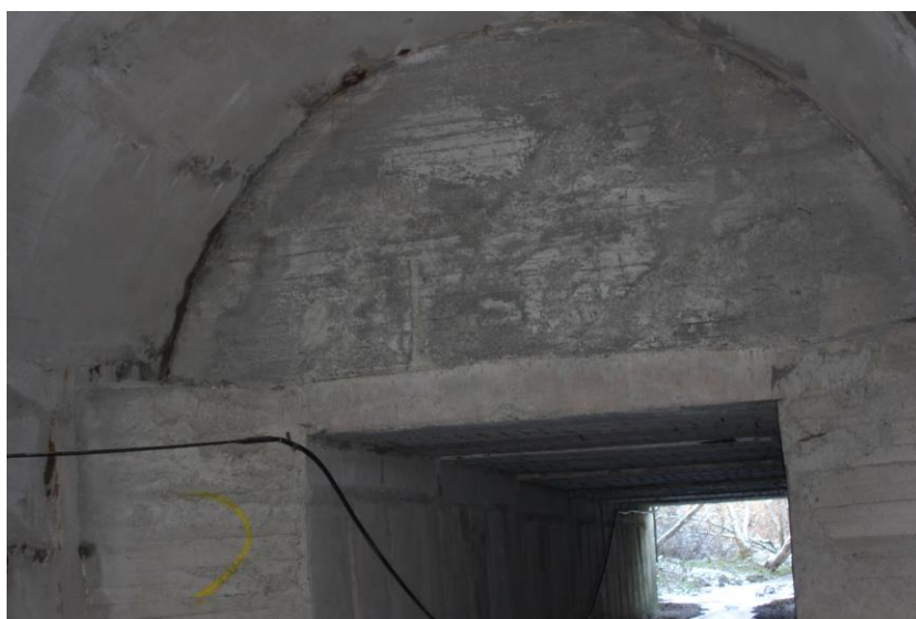
Obrázok – Prechod medzi klenbou a prefabrikátmi
