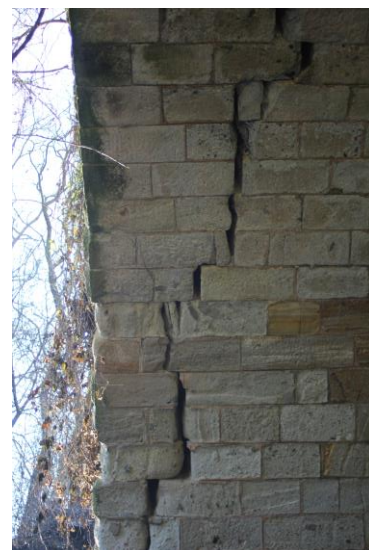
Obrázok – Odtrhnutá klenba vtok
